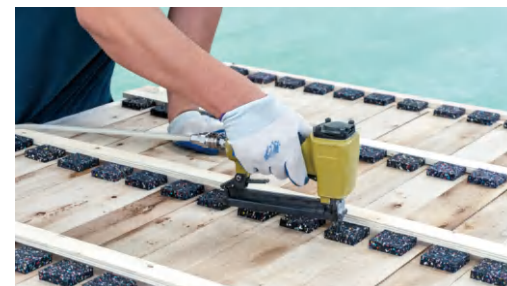
工厂预制装配式底部结构
